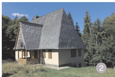
AȘA DA: construcție nouă cu acoperiș în 4 ape, inegale, cu racord rotunjit la intersecția dintre fețele acoperișului. Coșul de fum este amplasat pe fațada posterioară, aproape de acoperiș. arh. Laura Zaharia
