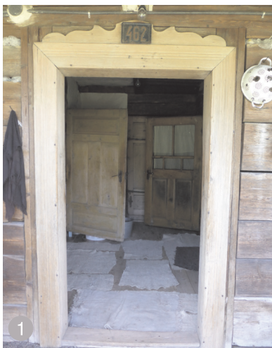
1 ușă cu blană; ancadramentul ușilor este generos – îmbracă și ascunde parțial montanții verticali din lemn ce formează cadrul ușii.
