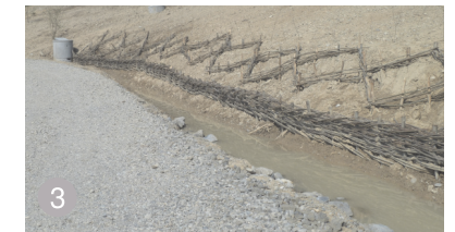
AȘA DA: consolidarea terenului cu împletituri de nuiele.
