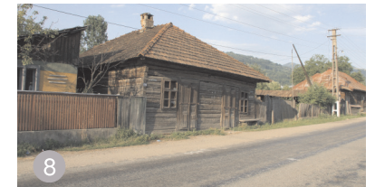
casă cu prăvălie, amplasată pe limita de proprietate într-un sat tipic maramureșan. Petrova
