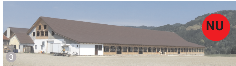
AȘA NU: deși au fost folosite elemente specifice arhitecturii tradiționale (prispa), acoperișul cu volumetrie masivă (monovolum) fără elemente descompuse conferă clădirii un aspect industrial, fără legătura cu arhitectura tradițională. Vadu Izei
