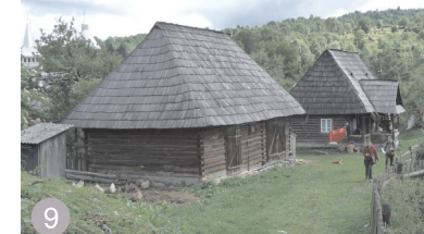
9 șură cu acoperiș în 4 ape; pereți din bârne de lemn, învelitoare din draniță, cu intersecțiile rotunjite și coamă petrecută; tâmplărie din lemn. Budești;
