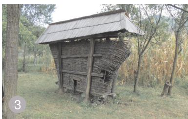
3 coș pentru mălai, cu o structură din stalpișori și grinzișoare din lemn, cu închideri perimetrice din scândură sau nuiele, acoperiș din lemn și învelitoare din draniță. Vadu Izei;
