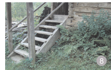
trepte de acces realizate din lemn;
