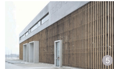
AȘA DA: construcție nouă, monovolum, cu caracter industrial; pereții finisați la exterior cu șipci din lemn constituie o suprafață expresivă, obținută cu mijloace simple; clădirea se încadrează bine în peisajul construit rural. arhitectura: EVELO ARCHITECTEN
