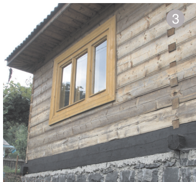
3 construcție nouă din bârne din lemn; talpa casei nu este din lemn de stejar dar este îmbibată cu o soluție hidrofugă. Budești
