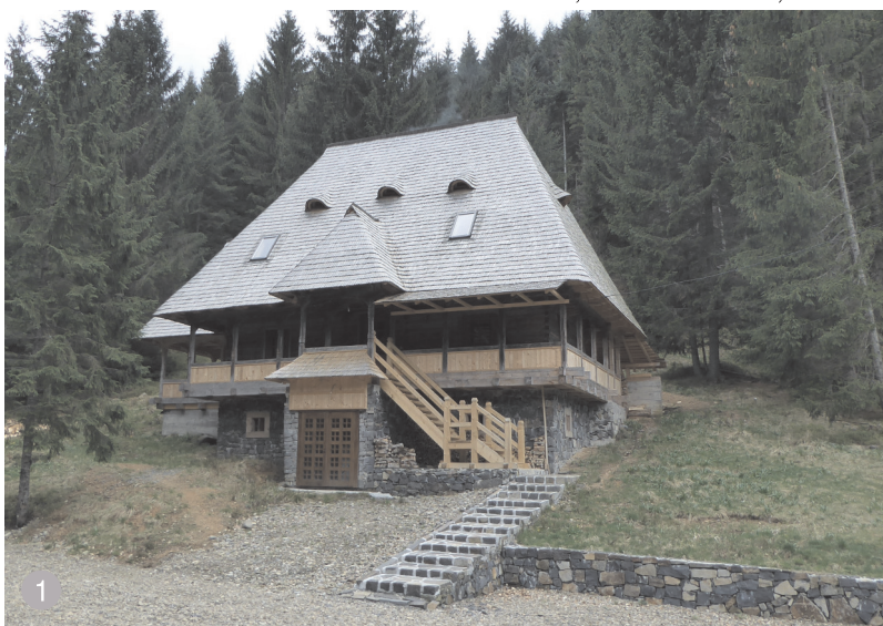
1 AȘA DA: casă tradițională strămutată. Demisolul nou construit este generos și se întinde pe toată suprafața casei; deoarece acest demisol înalt modifică imaginea originală a casei, este de dorit ca în timpul realizării proiectului de execuție să se găsească soluții pentru camuflarea într-o proporție mai mare a acestui nivel. Podul este amenajat cu spații utile (dormitoare, băi); iluminarea naturală a spațiilor de la mansardă se face prin ferestre în planul acoperișului care sunt o prezență discretă și sinceră totodată (este marcat astfel faptul că s-a intervenit asupra unei construcții tradiționale și că spațiile amenajate în pod au apărut în urma acestei intervenții contemporane). arh. Dorel Cordoș
