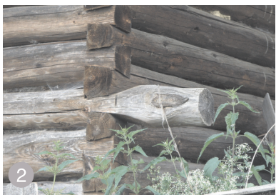
2 bârne din lemn de brad, îmbinate la colțuri "în coadă de rândunică";
