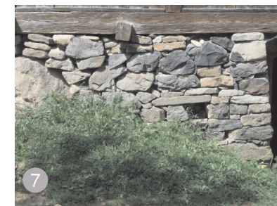
soclul din zidărie uscată de piatră;
