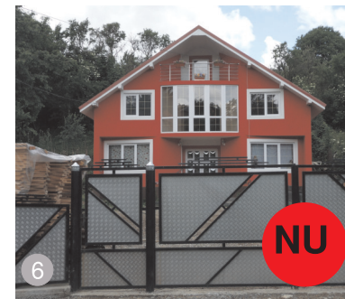
AȘA NU: nu se vor folosi culori saturate, stridente pentru fațadele caselor noi; nu se vor folosi materiale strălucitoare.
