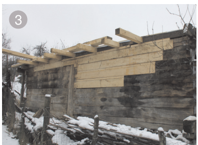
AȘA DA: casă tradițională în curs de reabilitare. Segmentele degradate ale bânelor din peretele nordic au fost înlăturate și înlocuite cu lemn sănătos;
