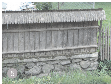
5 gard din scândură de lemn, simplu decorat, cu acoperiș din draniță. Budești;
