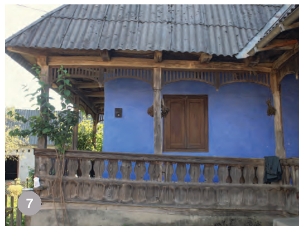
Strâmbu- stâlpi de târnaț ciopliți simpli și parapet traforat
