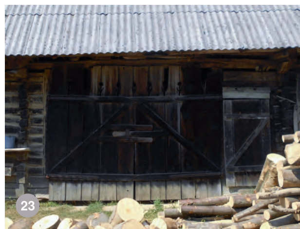
Libotin- poartă și ușă de șură. Deși executate simplu, din scânduri, există și o intenție decorativă: registrul superior al porții este traforat cu motiv floral.
