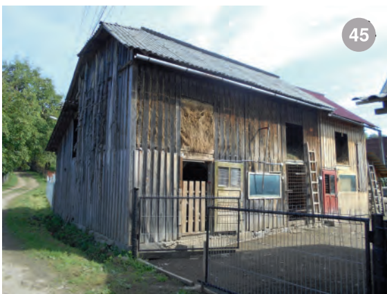
fânar din Lăpușu Românesc- structură etajată, cu cotețe la parter și fân la etaj
