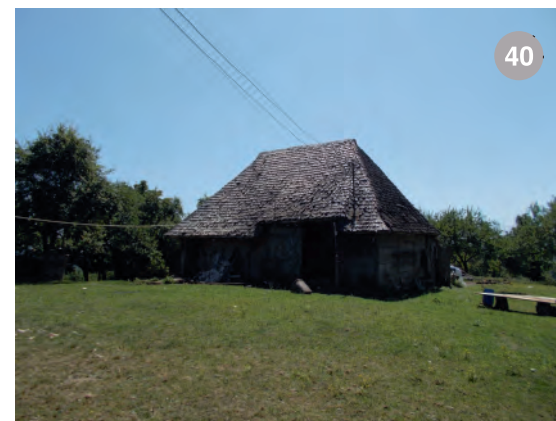
șură cu acoperiș în patru ape din Aspra- se observă evazarea acoperișului peste poarta carului, după modelul șurilor "cu gârbe" din zona Meseșului
