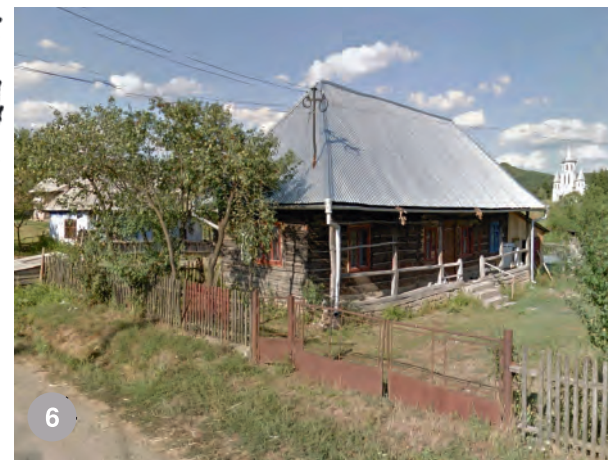
Libotin- târnaț cu "rudă", dispus pe toată lungimea casei
