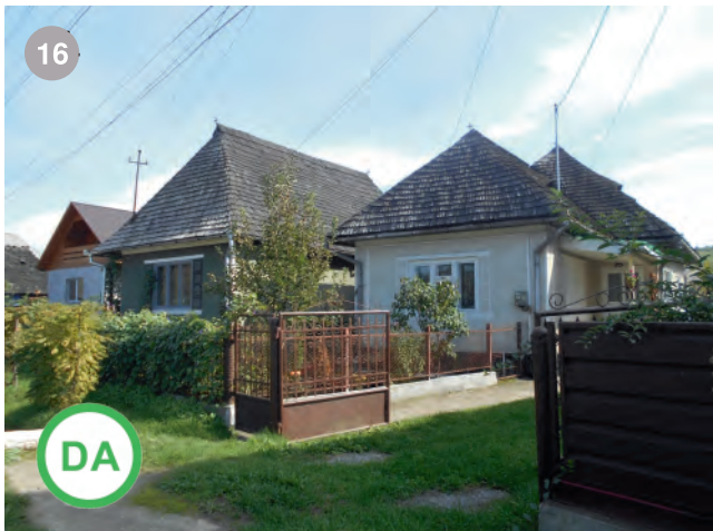
A A DA: case din perioada comunistă învelite cu șindrilă- Lăpușu Românesc
