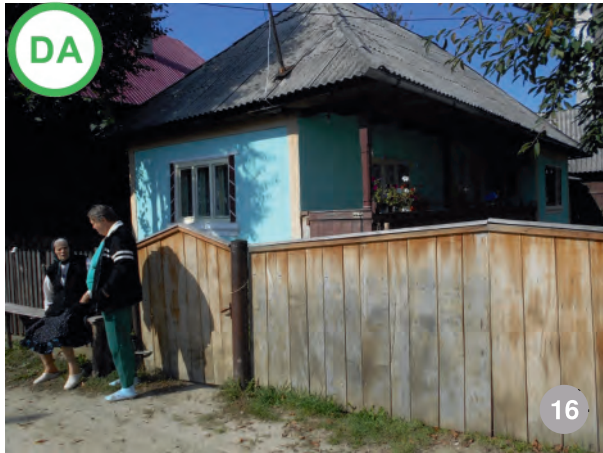
A A DA: Lăpușu Românesc- porți noi realizate conform tradiției locale
