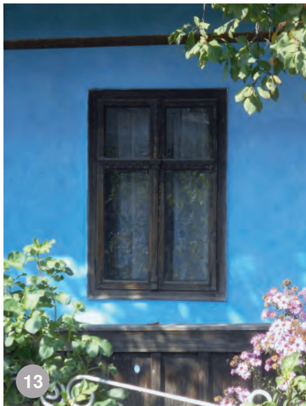
Lăpușu Românesc-tâmplărie cu foaia împărțită la 2/3 din înălțime; deși dulgherească, piesele sunt strunjite decorativ
