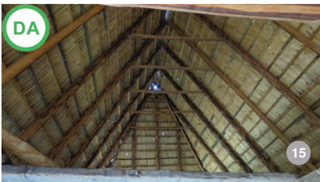
A A DA: șarpantă a unei locuințe tradiționale, reabilitată în forma originală
