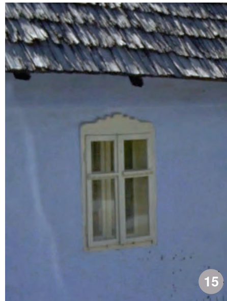
Groșii Țibleșului-tâmplărie cu foaia împărțită la 2/3 din înălțime; este montată pe un ancadrament decorativ din lemn
