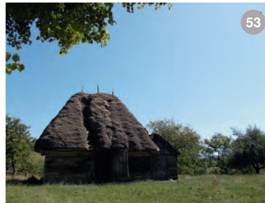
53 șură din Aspra- înălțimea acoperișului este dublă față de înălțimea pereților
