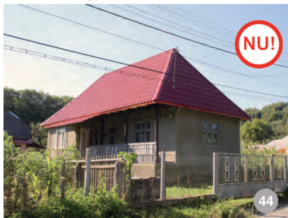
A A NU: acoperiș din Strâmbu reabilitat cu țigle de tablă; material nepotrivit, strălucitor, colorat strident
