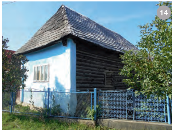
Lăpușu Românesc- tencuiala e prezentă pe fațadele principale, iar fațada din spate e din bârne netencuite
