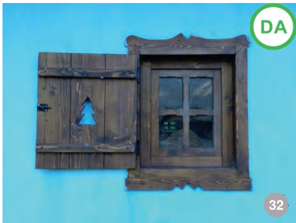
A A DA: Stoiceni- fereastră cu oblon reabilitată în forma originală
