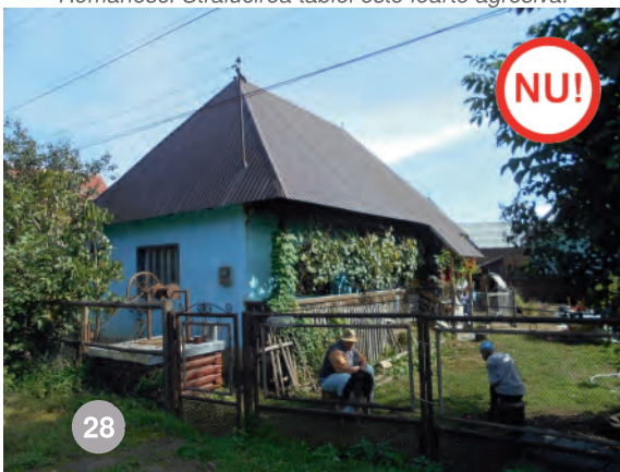
A A NU: acoperiș din tablă cutată gri mat în Lăpușu Românesc. Deși are o culoare mai adecvată decât tabla zincată, textura materialului e nepotrivită.
