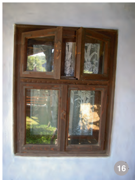
Măgoaja-tâmplărie cu foaia împărțită la 2/3 din înălțime; este lucrată simplu, dulgherește
