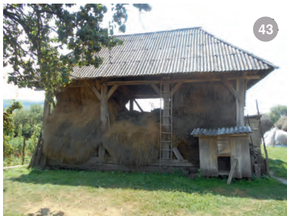
fânar din Libotin. Este tipul cel mai frecvent întâlnit: structură simplă de lemn fără pereți, acoperită în patru ape
