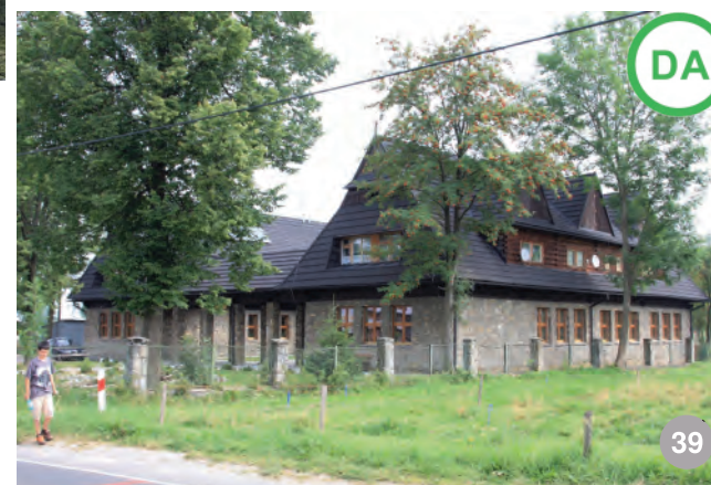
A A DA: școală în Chokolow/ Polonia- volum pavilionar, acoperit cu șindrile de tablă- soluție acceptabilă doar pentru clădiri mari situate în afara vetrei satelor și doar după epuizarea altor soluții
