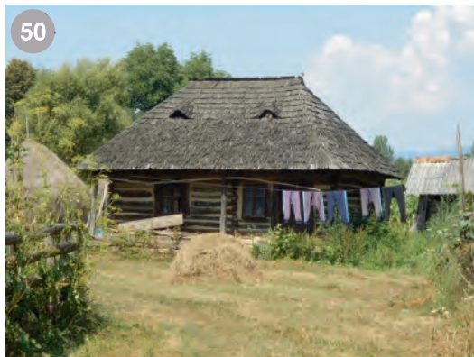
50 casă din Libotin- înălțimea acoperișului este egală cu o dată și jumătate din înălțimea pereților
