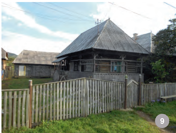
Lăpușu Românesc- târnaț cu stâlpi și console simple
