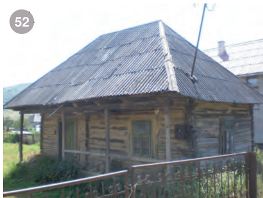
52 casă din Libotin- înălțimea acoperișului este egală cu înălțimea pereților
