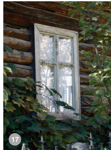
Lăpușu Românesc-tâmplărie interbelică cu foaia împărțită la 2/3 din înălțime; piesele sunt strunjite decorativ
