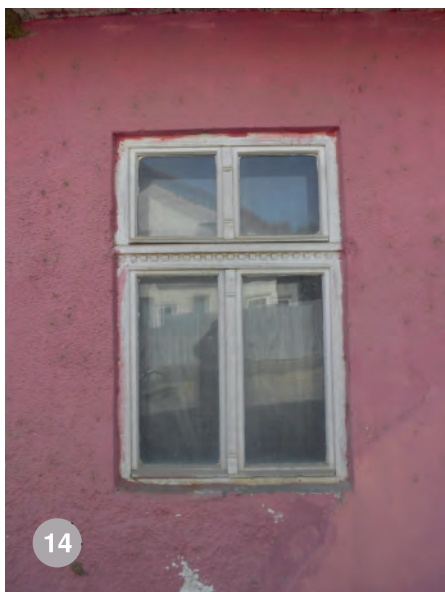
Lăpușu Românesc-tâmplărie cu traversă la 2/3 din înălțime și ochiuri superioare mobile; piesele sunt lucrate decorativ
