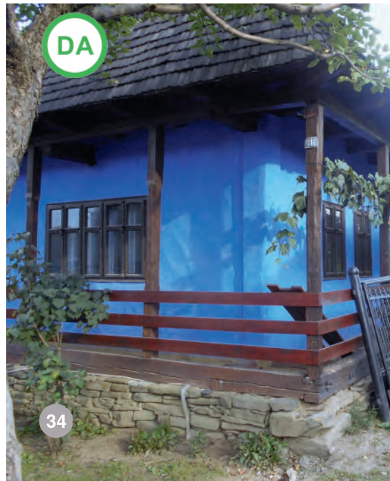
A A DA: Lăpușu Românesc- tâmplării reabilite; pe fațada scurtă, montantul lat dintre goluri a fost înlocuit cu un ochi de fereastră. Soluția adaugă lumină în interior, dar păstrează totodată proporțiile golurilor originale.
