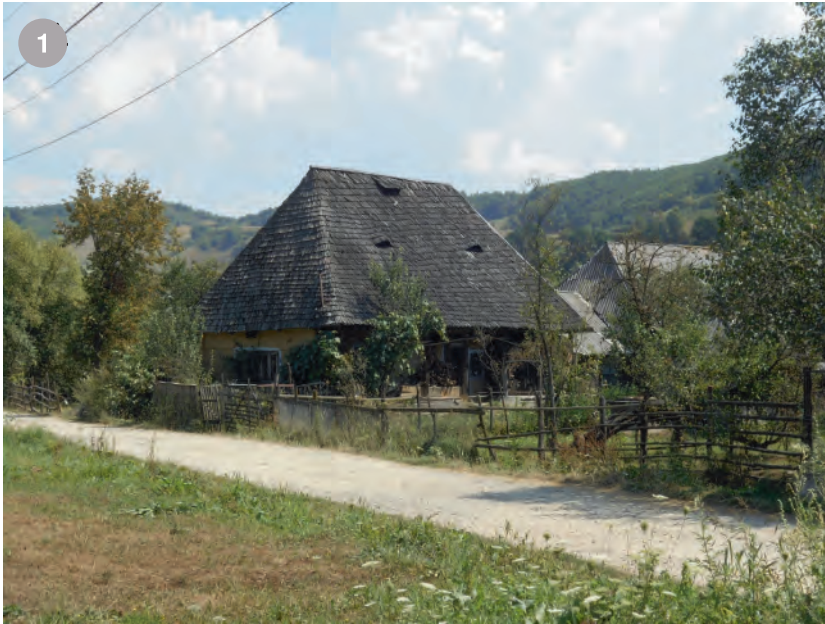
casă din Libotin cu acoperiș abrupt și învelitoare din șindrilă
