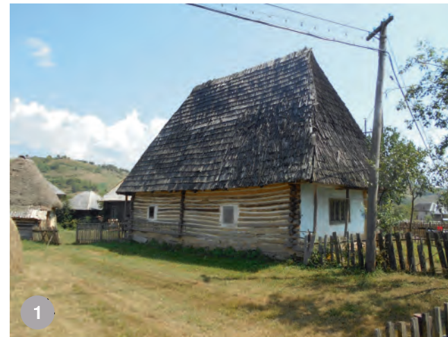
casă în Cupșeni: pereți din bârne prinse "în cheutori". Fațada din spate nu e tencuită decât la îmbinările bârnelor, celelalte sunt tencuite integral și zugrăvite "mnieriu"
