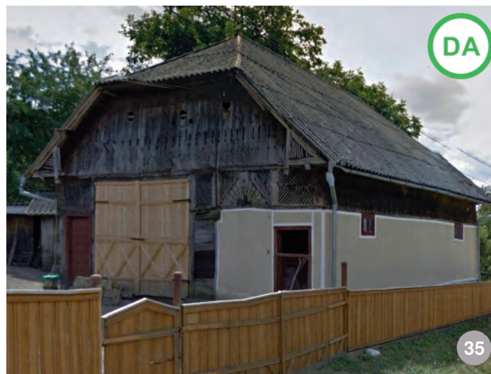
A A DA: Vima Mare- poartă nouă de șură, executată în tehnica tradițională
