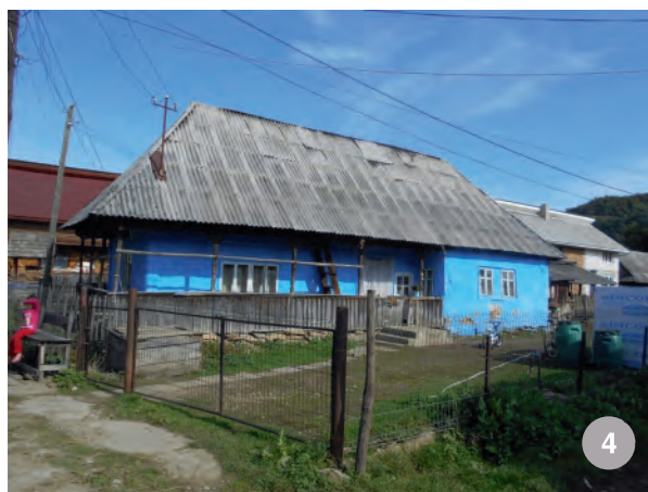
Lăpușu Românesc- târnaț cu parapet plin dispus pe două laturi ale casei
