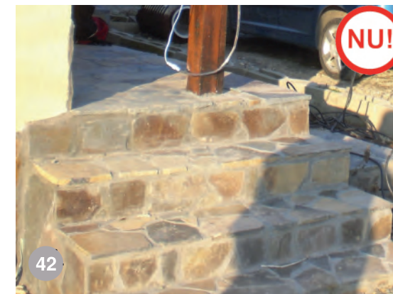
A A NU!- trepte din beton placate cu piatră dispusă neregulat- așa-numitul stil "rustic". În realitate, zidăria de piatră nu a arătat niciodată în acest fel; acest mod de dispunere a pietrei sfidează logica constructivă.
