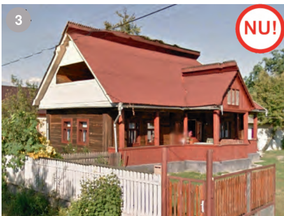
A A NU: Dobricu Lăpușului-timpan modificat prin perforare cu o fereastră; tratarea întregului acoperiș este greșită
