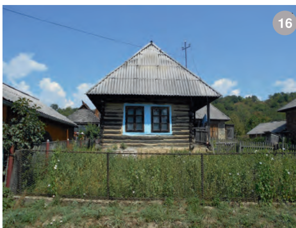
Libotin- spațiile dintre bârne sunt lipite cu lut, iar pe conturul ferestrelor s-a tencuit un panou colorat cu "mnieriu"
