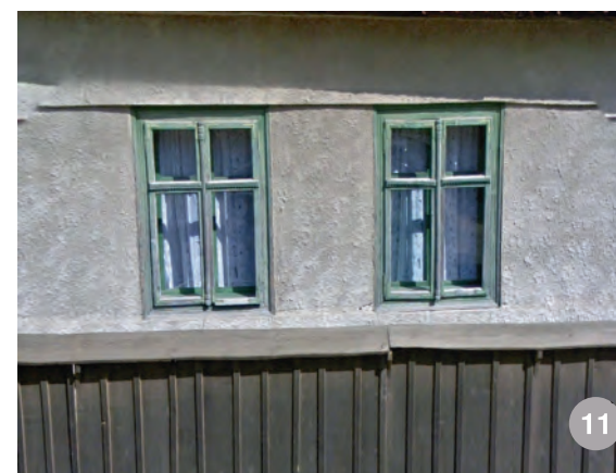
Groșii Țibleșului-ferestre separate, cu foi împărțite la 2/3 din înălțime
