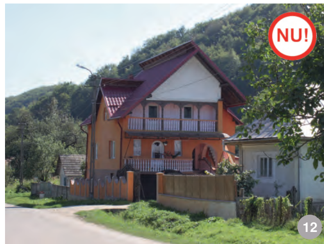
A A NU: Măgoaja- casă cu acoperiș în două ape, cu ape suprapuse și lucrămă masivă; a rezultat un acoperiș complicat, prost integrat în peisaj și în cadrul construit
