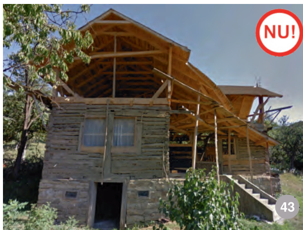
A A NU: casă din Brebeni, cu acoperișul modificat într-un mod complicat, străin arhitecturii locale
