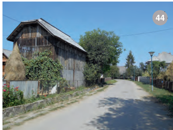
fânar din Rogoz- structură etajată, cu pereți din șipci și învelitoare în patru ape cu timpane teșite
