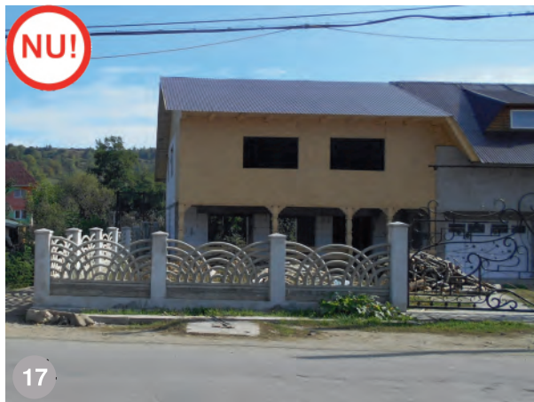
A A NU: clădire nouă în Lăpușu Românesc, cu pereți din OSB placat cu polistiren.
