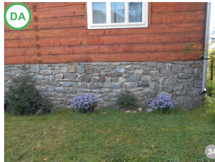
A A DA: soclu nou din blocuri de piatră în Lăpușu Românesc
