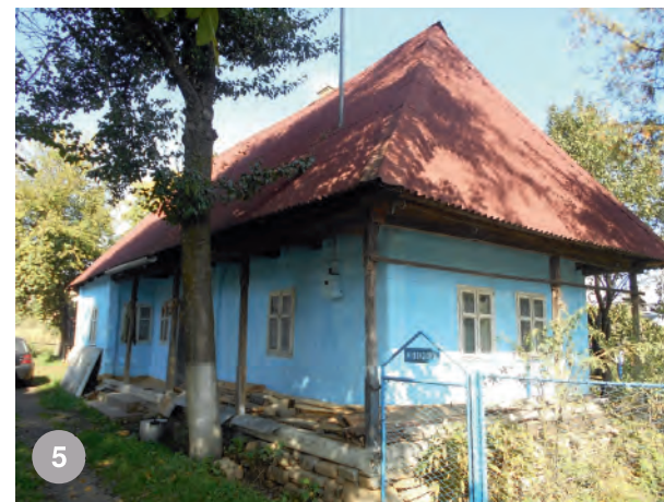
Lăpușu Românesc- târnaț fără parapet, dispus pe toată lungimea casei
