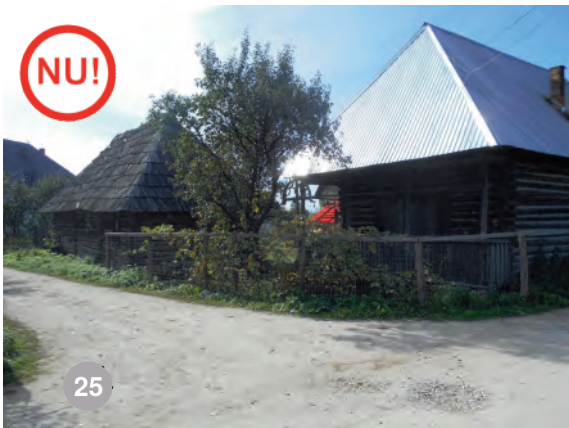
A A NU: acoperiș din tablă cutată zincată în Lăpușu Românesc. Strălucirea tablei este foarte agresivă.
