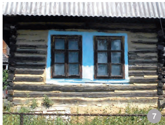
Libotin-ferestre cu foi împărțite în trei ochiuri și cu montant central; sunt lucrate simplu, dulgherește
