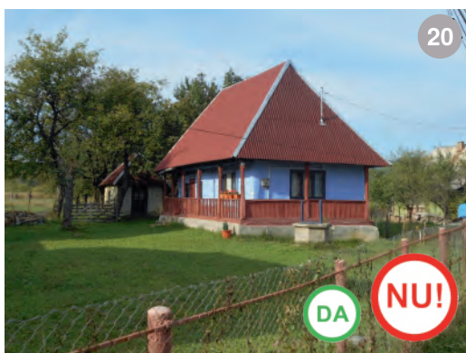
Lăpușu Românesc; deși a fost păstrată forma acoperișului- A A DA!- coloritul și textura plăcilor bituminoase sunt nepotrivite- A A NU!
