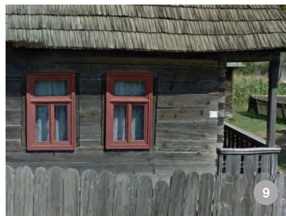
Groșii Țibleșului-ferestre separate, cu traversă la 2/3 din înălțime; traversa și montantul sunt sculptate decorativ
