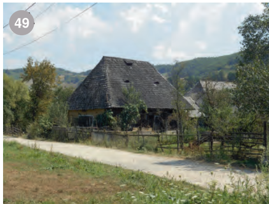
49 casă din Libotin- înălțimea acoperișului este dublă față de înălțimea pereților
