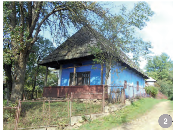
casă din Lăpușu Românesc, cu fereastra dublă specifică Lăpușului și obloane pe fațada secundară
