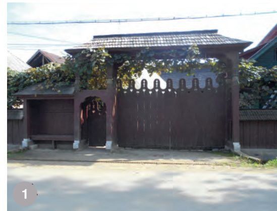
Lăpușu Românesc - poartă înaltă de lemn cu intrări pentru vehicule și persoane și cu nișă de ședere
