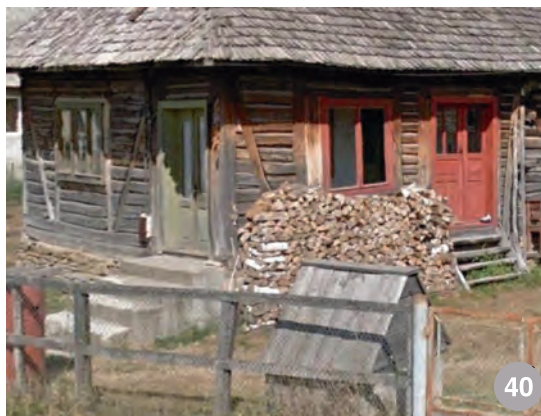
trepte vechi de lemn- A A DA!- și scară din beton- A A NU!- Suci de Sus
