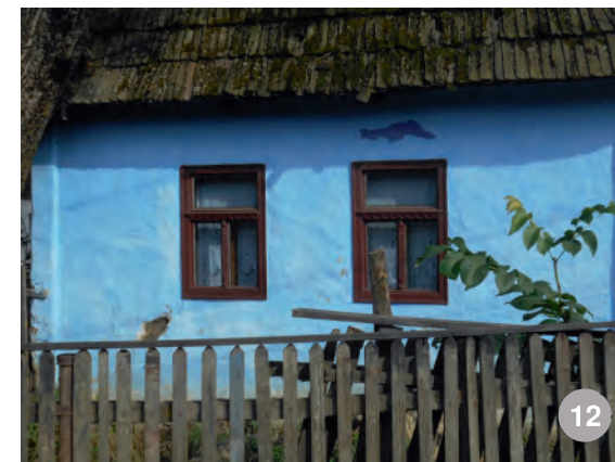
Lăpușu Românesc-ferestre separate, cu traversă la 2/3 din înălțime; traversa și montantul sunt sculptate decorativ
