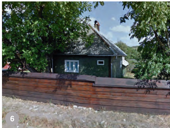
Groșii Țibleșului- gard din scânduri orizontale îmbinate
