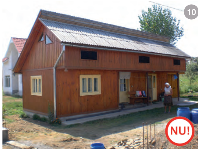
A A NU: Libotin- casă cu volumetrie străină tradiției locale, având acoperiș cu pante inegale
