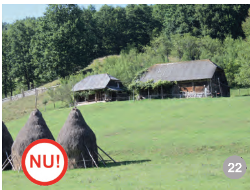
A A NU: acoperișuri din plăci de azbociment în Valea Cășeielului . Nu au valoare estetică și nu sunt sănătoase.
