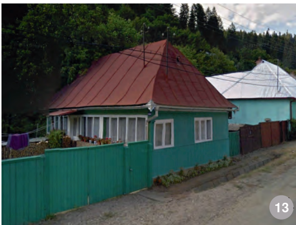
Băiuț- casă specifică zonei miniere, cu pereți placați cu scânduri verticale
