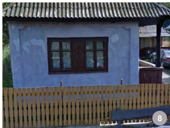
Suciu de Sus- ferestre cuplate central, cu foaie împărțită la 2/3 din înălțime
