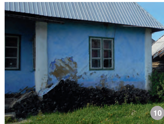
Libotin-ferestre cu foi împărțite în trei ochiuri și cu montant central; sunt lucrate simplu, dulgherește
