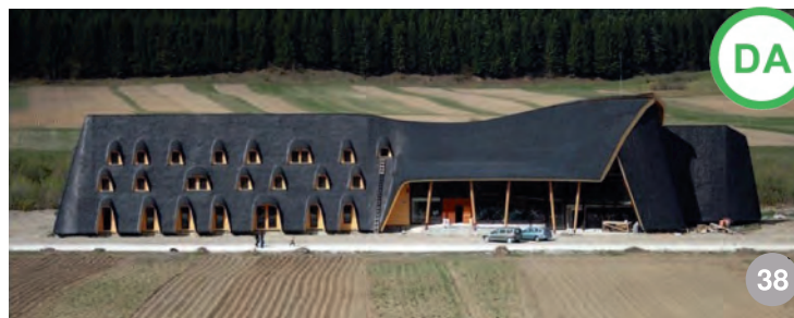
A A DA: clădire cu gabarit mare acoperită cu șindrila- Centrul de vizitare a Parcului Național Piatra Craiului- arh. George Postelnicu, Mihai Nuță
