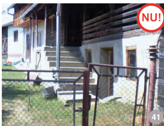
A A NU!- trepte din beton la Libotin
