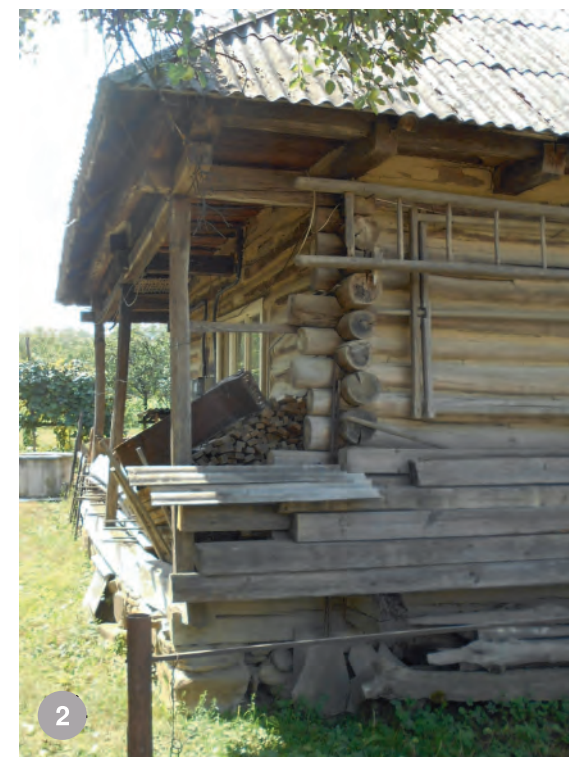
casă în Libotin: pereți din bârne prinse "în cheutori". Îmbinările bârnelor sunt lipite cu lut
