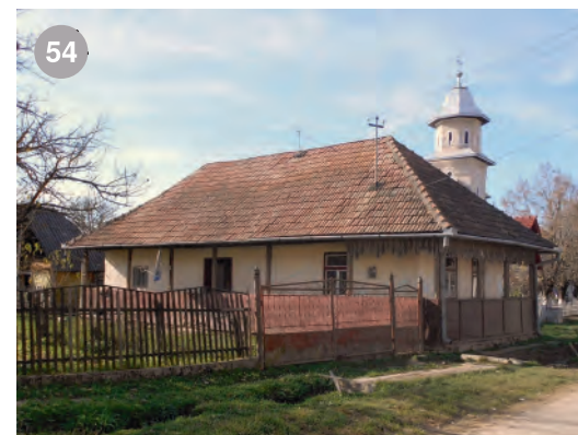
casă din Nadiș- înălțimea acoperișului este egală cu o dată și jumătate din înălțimea pereților
