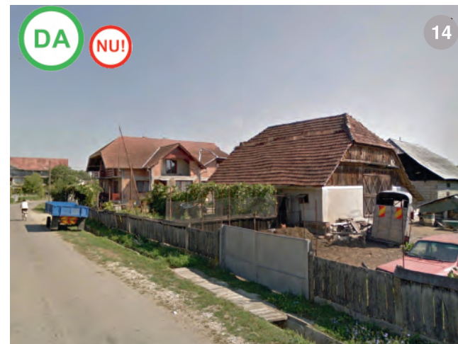
casă nouă în Sălsig; acoperișul preia forma învelitorii tradiționale cu apă scurtă spre stradă- AȘA DA- , dar casa este prea voluminoasă, fiind mai înaltă decât șura- AȘA NU- regula în gospodăria tradițională este că toate volumele se subordonează volumului șurii
