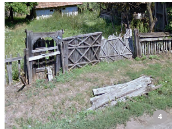
Urmeniș- rămășițele unei porți acoperite. Stâlpii porții s-au prăbușit, s-au păstrat panourile porții mari și poarta mică.
