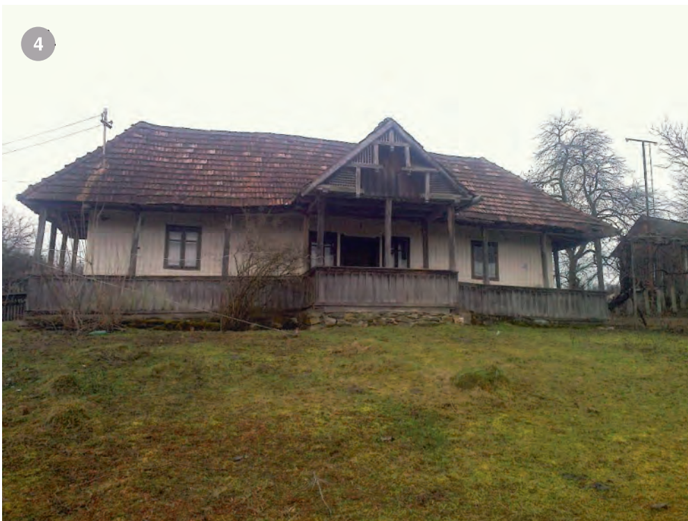
casă din Băsești acoperită în patru ape, având pe centrul fațadei "friguria" acoperită în două ape
