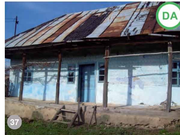
AȘA DA- casă din Stremț- soclul este tencuit cu lut
