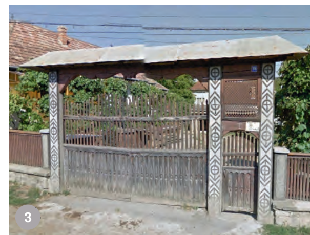
Chelița- poartă cu panouri din scânduri profilate și grătar de șipci montate pe stâlpi de beton; posibil să fie o poartă veche recuperată în perioada comunistă
