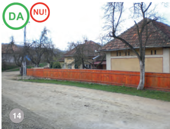
gard nou în Ulciug, realizat din scânduri montate vertical- AȘA DA. Culoarea este stridentă- baiț în nuanța "cireș"- AȘA NU!
