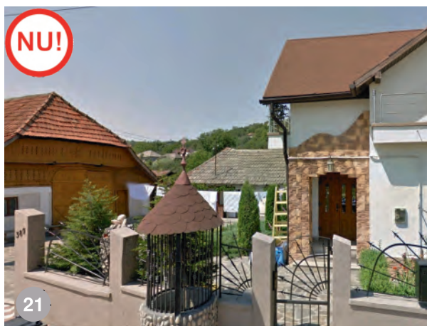
AȘA NU: casă nouă în Gârdani- la intrare s- a aplicat un placaj de similpiatră- atât materialul, cât și modul de dispunere sunt nepotrivite
