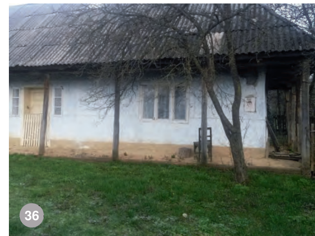
casă cu talpa așezată direct pe sol la Băsești
