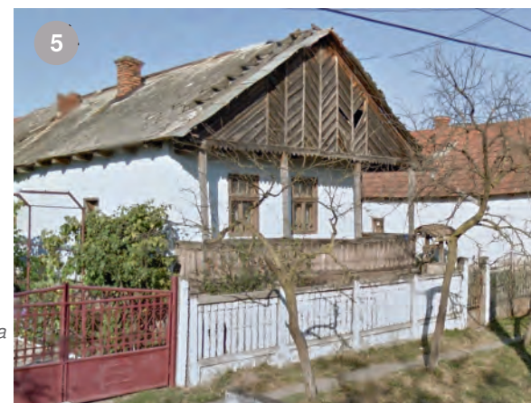
Corund- timpan drept executat din șipci dispuse la unghiuri diferite
