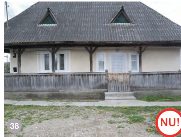
AȘA NU- casă din Sălsig- soclul este tencuit cu ciment
