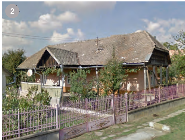
casă din Homorodu de Mijloc- acoperiș tipic codrenesc cu o apă scurtă spre stradă; acces protejat de "frigurie" acoperită în două ape
