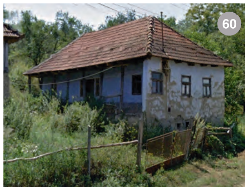
casă din Oarța de Sus cu târnațul ascuns de o a treia travee. Traveea care închide târnațul are fereastră identică cu cele ale casei
