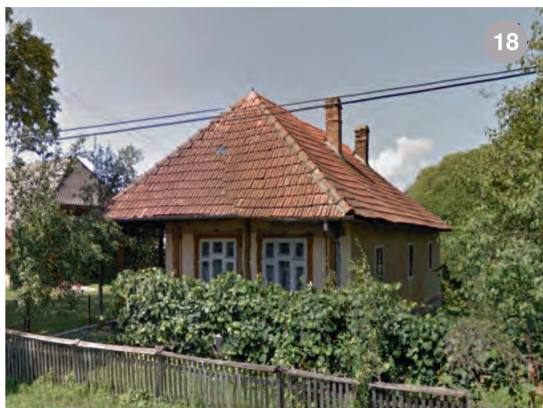
casă din Asuaș de Jos- se văd coșurile de fum pe apa lungă posterioară a acoperișului
