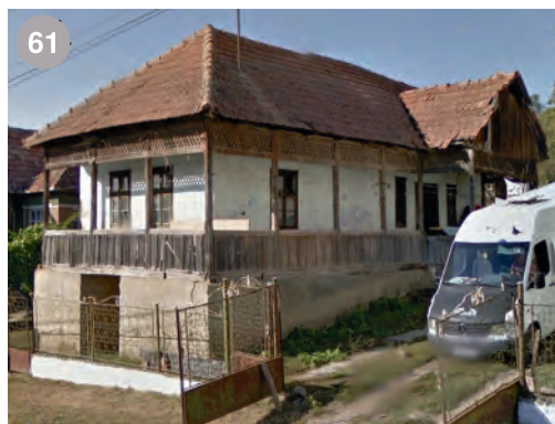
casă din Bogdand cu beci și parter înalt. Înălțimea mare a parterului face ca și ferestrele să fie înalte
