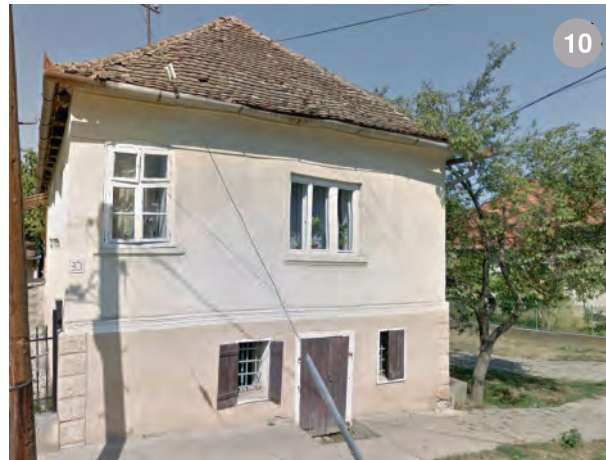
10 casă maghiară din Hodod. E acoperită în patru ape, învelită cu țiglă solz și are streșini scurte. Este un tip de casă specific regiunii Tövishát.
