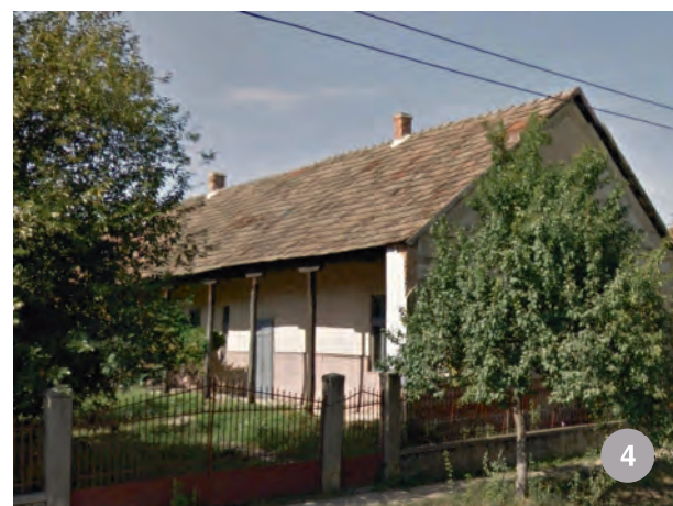
Beltiug- târnaț fără parapet inclus în fațada laterală spre stradă
