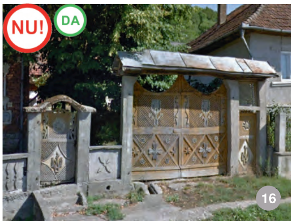
poartă în Chelița- deși panourile sunt decorate conform tradiției locale- AȘA DA! , structura din beton e greoaie și fără valoare estetică- AȘA NU!
