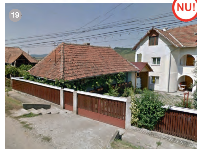
18, 19- gospodărie din Oarța de Jos, formată din trei locuințe din etape constructive diferite. Clădirile relaționează prost între ele- AȘA NU!
