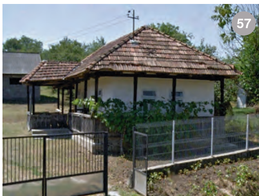
casă din Oarța de Jos- înălțimea acoperișului este egală cu înălțimea pereților; învelitoarea are pantă mică, fapt care afectează proporțiile clădirii
