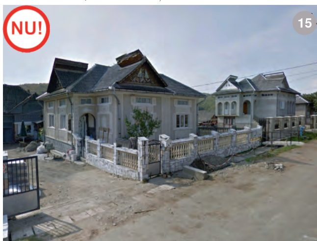
AȘA NU: Poiana Codrului- învelitori cu ape suprapuse și cu exces de forme amestecate, rezultând o imagine incoerentă și obositoare
