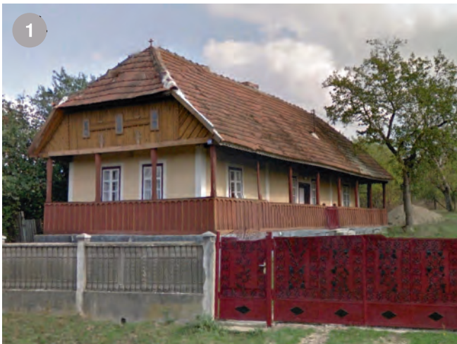
casă din Homorodu de Sus- acoperișul este specific codrenesc, în patru ape, cu apă scurtă spre drum și timpan de lemn tratat decorativ.
