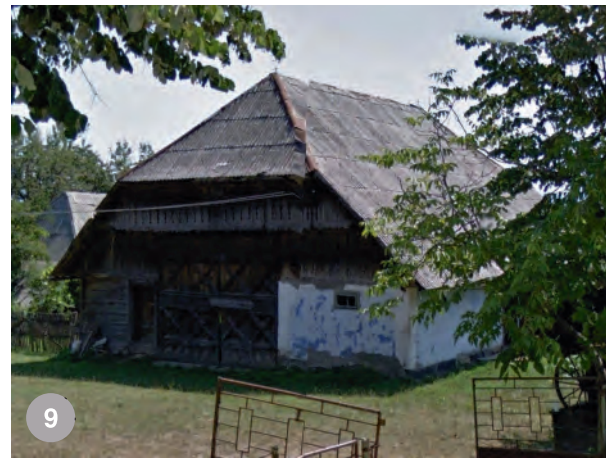
9 șură din Sârbi/ Fărcașa. Etajul fânului este închis cu un trafor delicat
