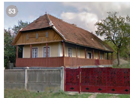
casă din Homorodu de Sus: înălțimea acoperișului este o dată și jumătate din cea a pereților
