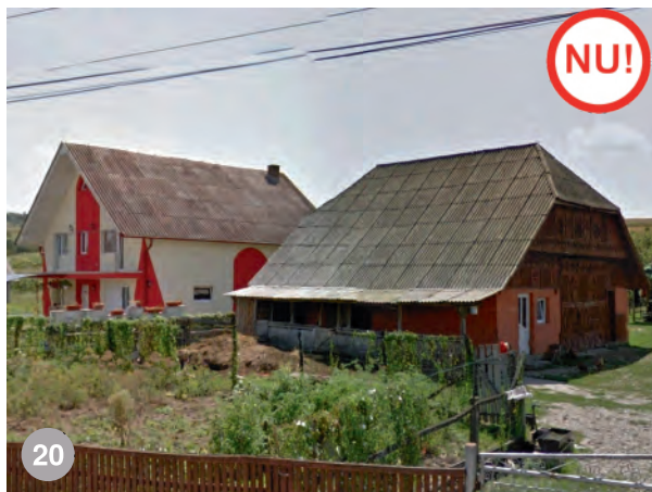
AȘA NU: casă nouă în Băița de sub Codru, zugrăvită cu accente de culoare tare în desene neregulate; șura de alături a fost reabilitată și vopsită într- o culoare nespecifică zonei
