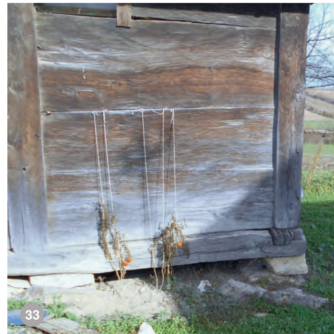
bucătărie de vară pe "boci" la Motiș; nu s-au mai așezat pietre ca umplutură a soclului, structura fiind astfel vizibilă
