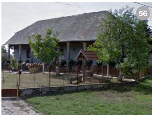
casă din Tătărești cu parter foarte înalt și stâlpi galbați din zidărie pe toată înălțimea parterului
