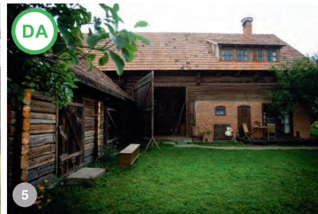
AȘA DA: șură în Delnița, Harghita- transformată în pensiune și centru cultural; arh. Esztány Győző, foto Esztány Győző
