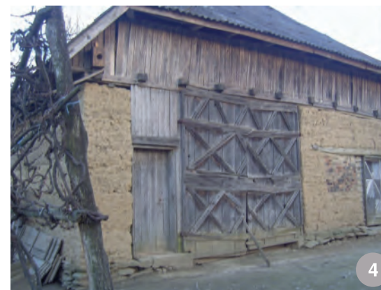
șură din Asuaju de Sus- finisajul a căzut, rămânând vizibil stratul suport- lipitura de lut.
