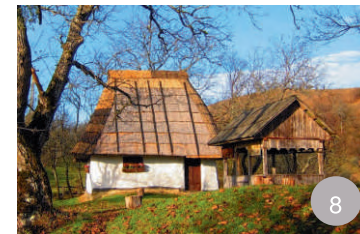
Căsuța de vacanță în Berchezoaia - modificarea acoperișului pentru a răspunde cerințelor funcționale contemporane, dar respectând REGULI ARHITECTURALE STRICTE.
