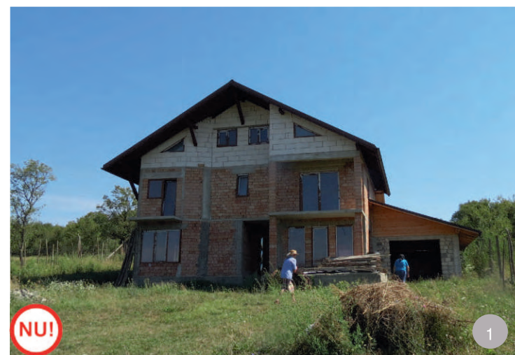
ASA NU - Tâmplărie care nu respectă formă și materiale locale
