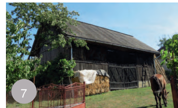
Fânăr cu acoperiș în 2 ape
