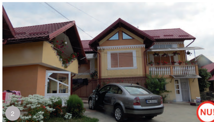
ASA NU - Tâmplărie nouă care nu respectă formă și materiale integrate în specificul local
