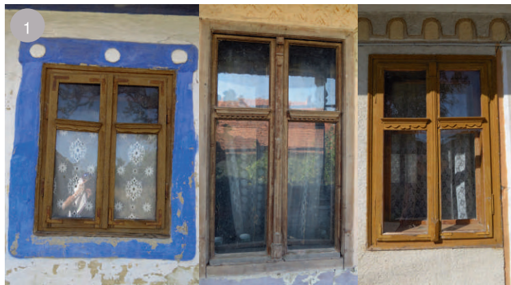
Fereastră dublă, fiecare față având două canaturi cu traversa și montantul decorat.
