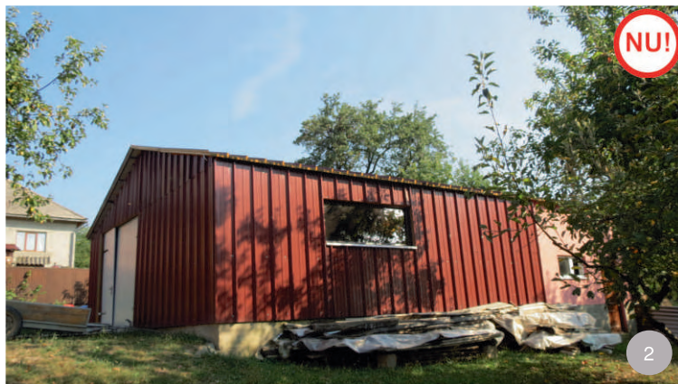
AȘA NU: Utilizarea panourilor izolate ca închideri de fațadă este interzisă. Se accepta finisarea metalică pe suprafețe foarte mici, atunci când fluxul tehnologic sau condițiile obiective de altă natură o impun.
