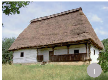
Casă cu acoperiș din paie din Preluca Nouă
