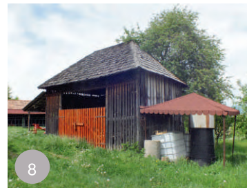
Fânăr cu acoperiș în 4 ape
