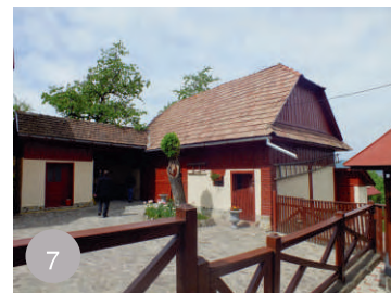
Șură în Groși - reamenajare a grajdului și șurii în spații anexe de utilitate actuală - atelier, bucătărie de vară, colniță.
